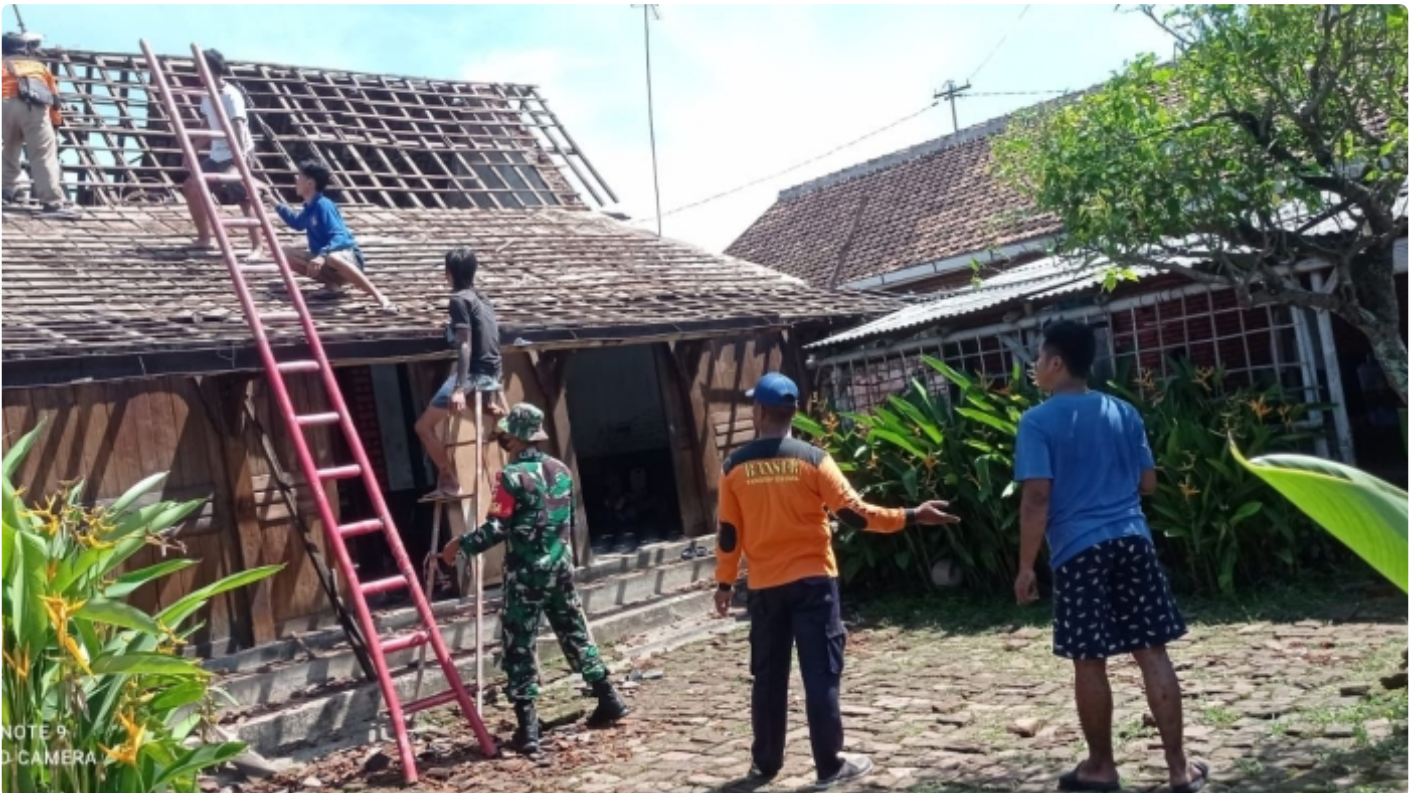
(Foto Istimewa) Gotong Royong pemasangan Genteng Rumah Warga
