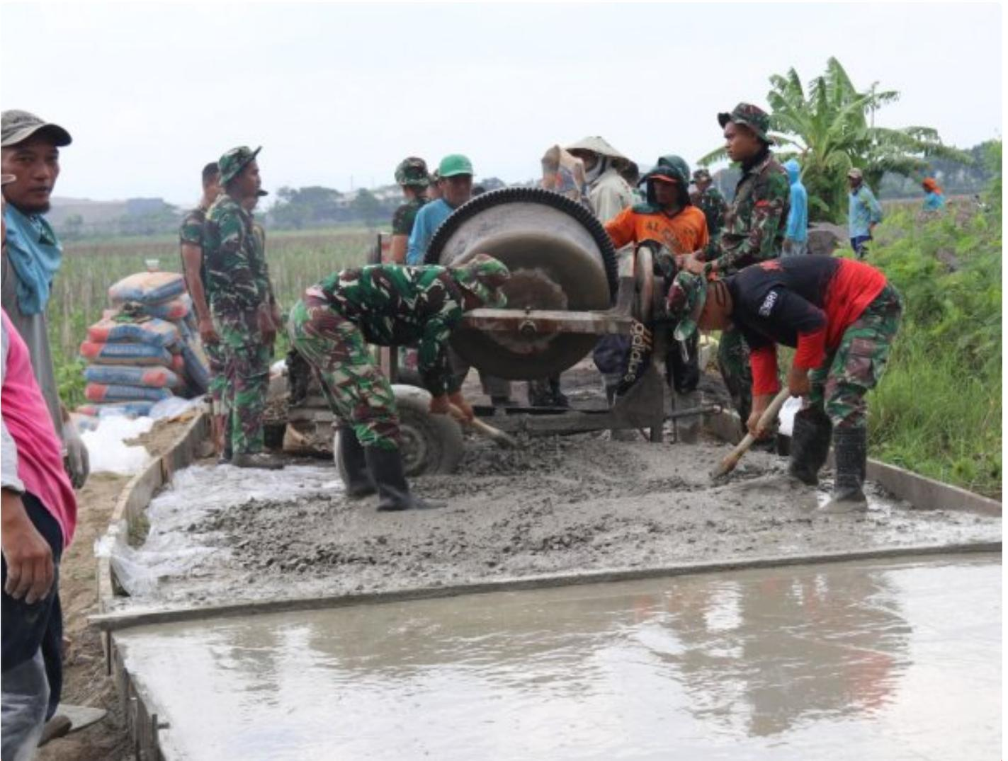
*(Foto istimewa) Pengecoran JUT Sasaran Fisik TMMD Reg Ke 116 Kodim 0722/Kudus*
