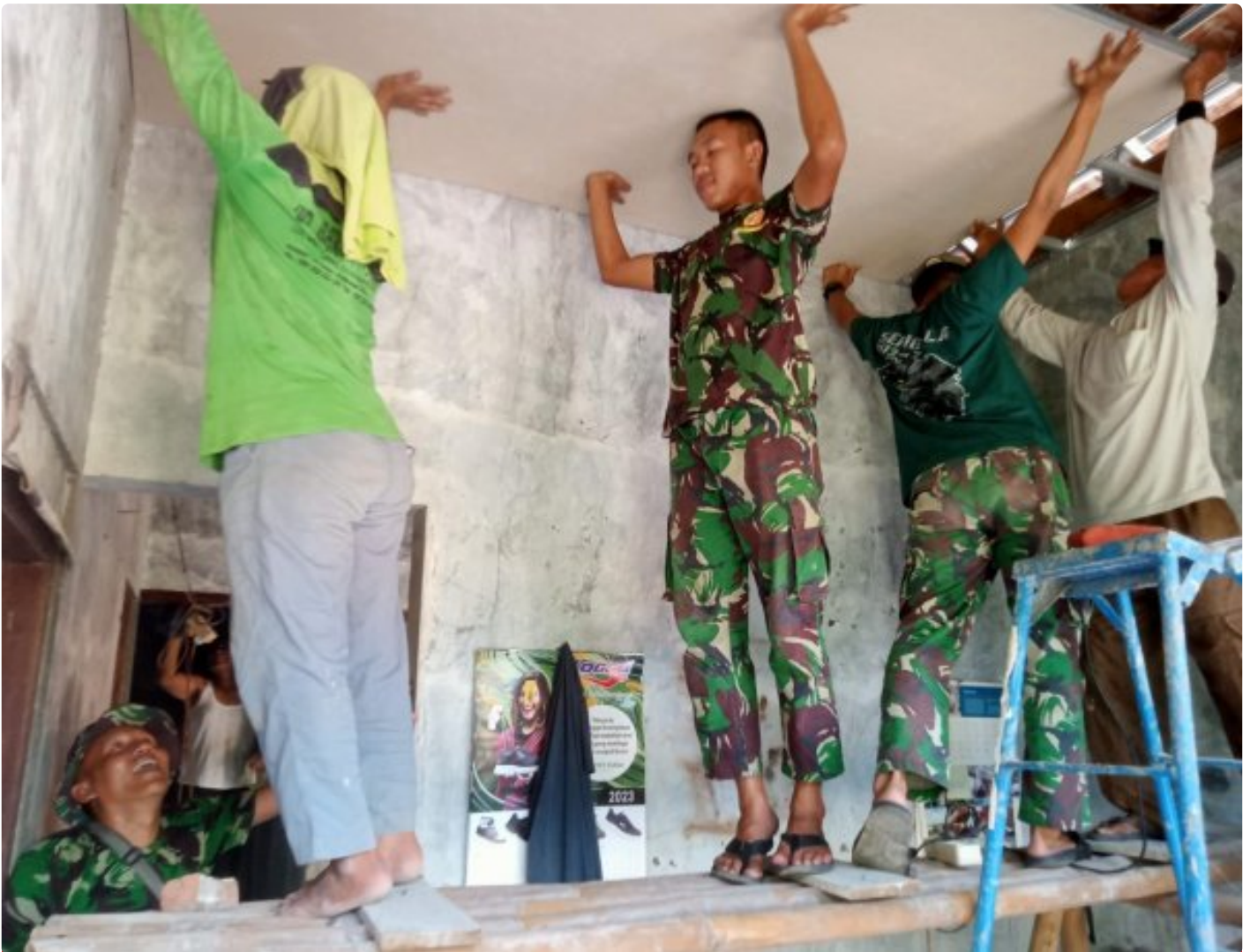
(Foto Istimewa) Pemasangan Plafon RTLH TMMMD 116 Kodim 0722/Kudus
