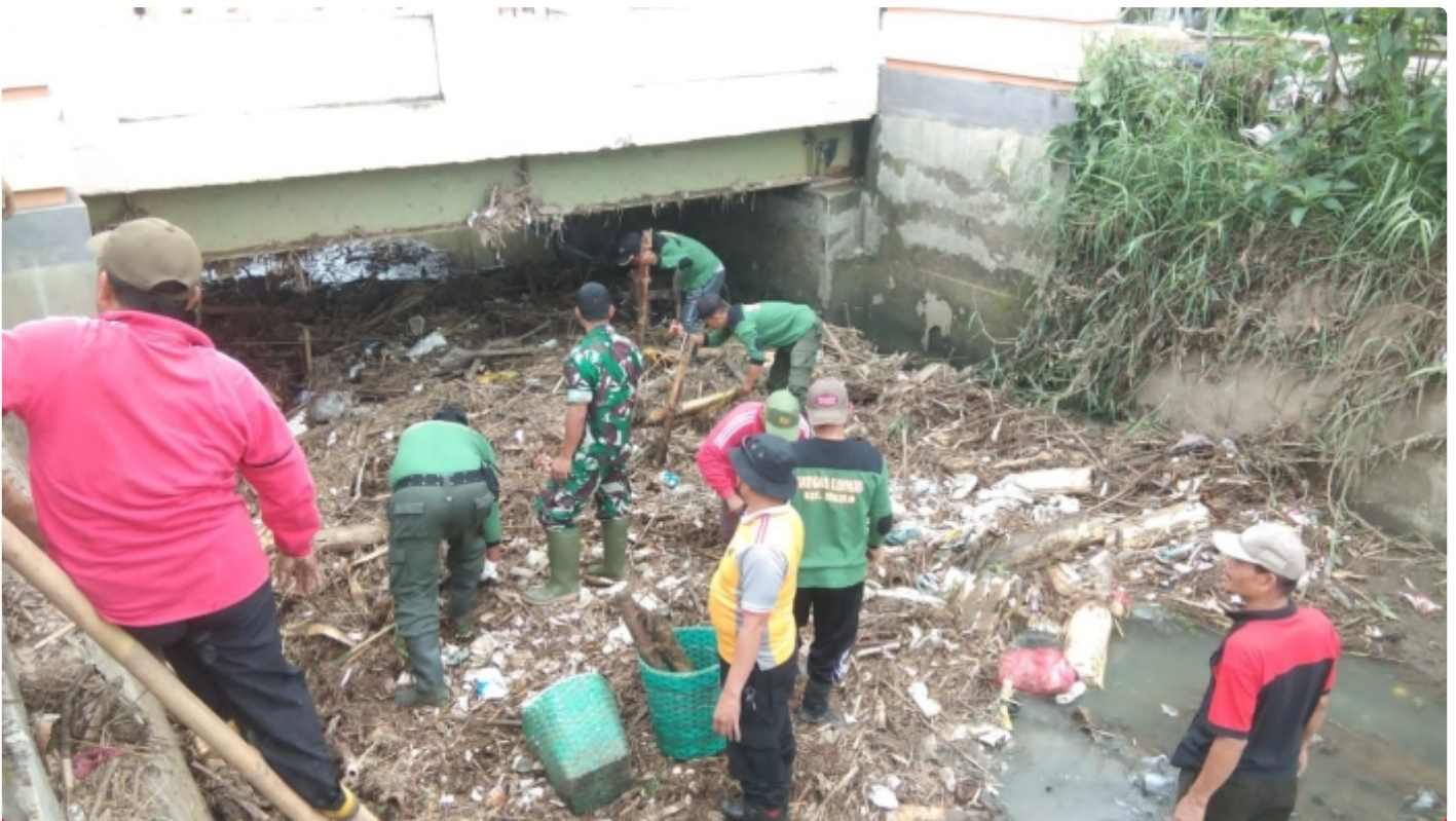
(Foto istimewa) Gotong Royong Pembersihan Aliran Sungai
